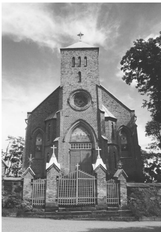
Veprių bažnyčios pagrindinis fasadas.
