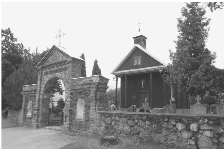
Sližių koplyčios architektūrinis kompleksas: vartai, aptvara, koplyčia. A. Petrašiūno nuotr. 2010 06 22
